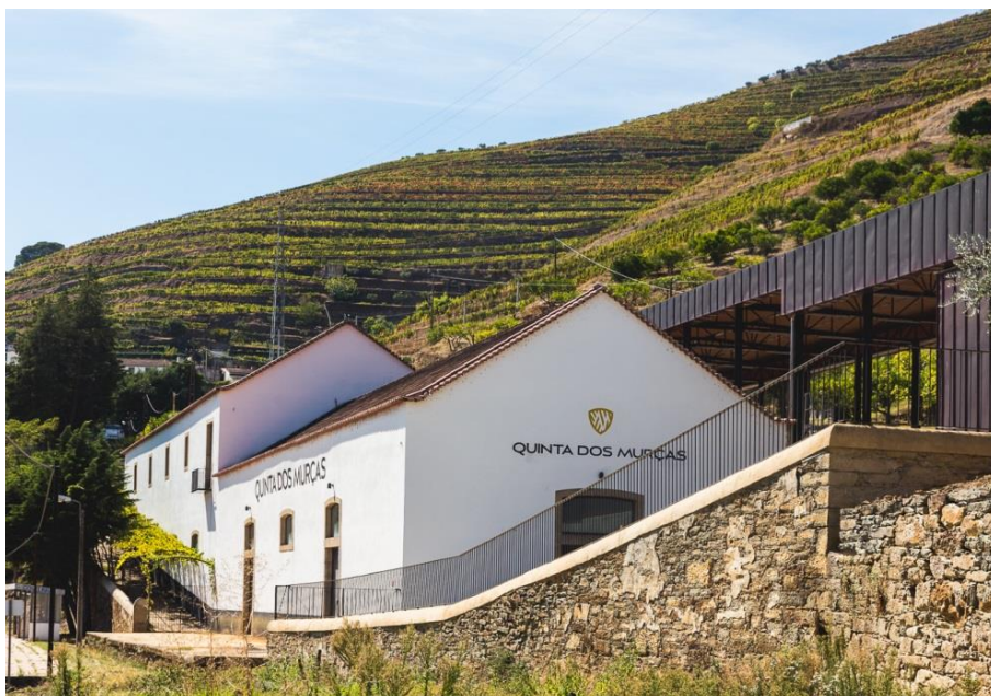
Remodelação e Ampliação da Adega da Quinta dos Murças, em Covelinhas, concelho de Peso da Régua, de João Botelho e Miguel Martins de Oliveira;
