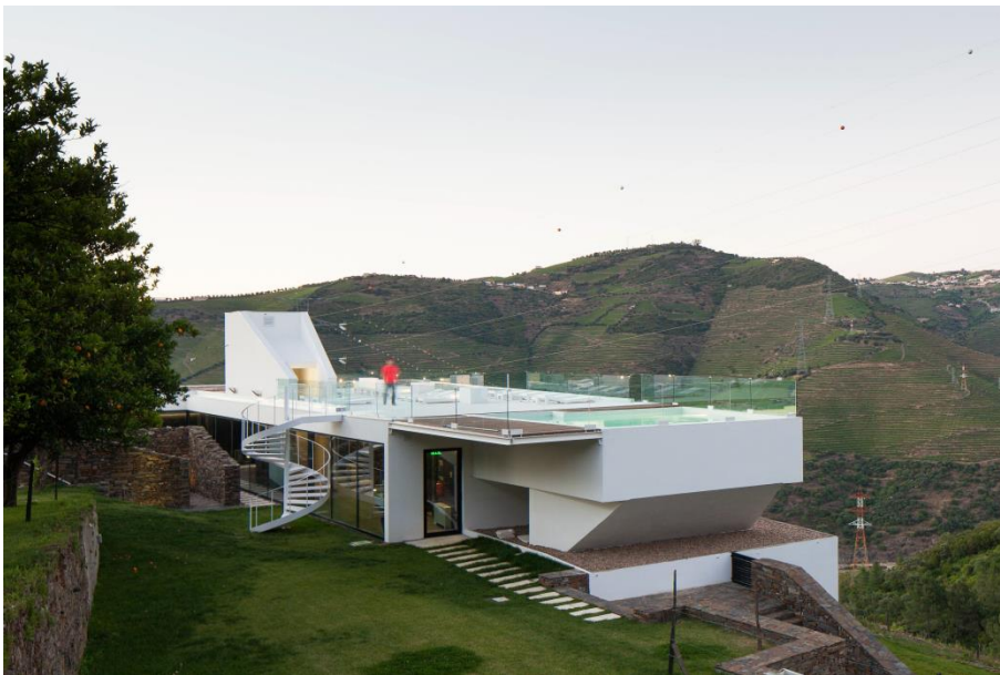
Hotel Rural da Quinta de Casaldronho, em Valdigem, concelho de Lamego, de Rui Branco Cavaleiro;
