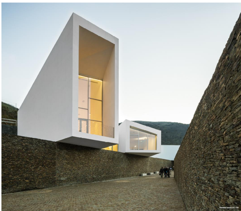
Centro de Alto Rendimento do Pocinho, no Pocinho, concelho de Vila Nova de Foz Côa, de Álvaro Fernandes Andrade.
