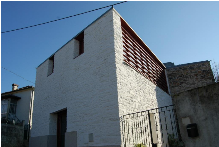
Construção do Centro Interpretativo da Fonte do Milho, em Canelas, concelho de Peso da Régua, de Paulo Moura;
